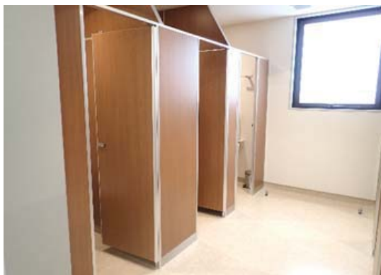
講義棟便所改修(札幌キャンパス)
