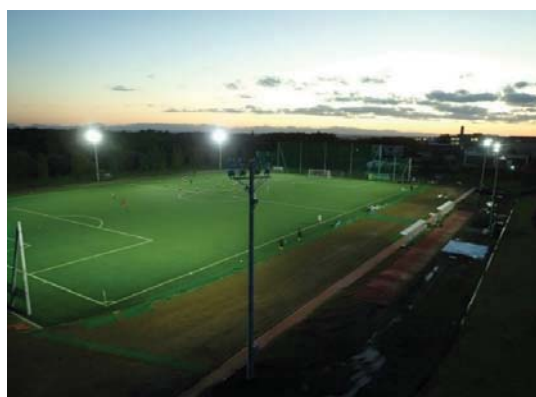
屋外照明設備工事(岩見沢キャンパス)
